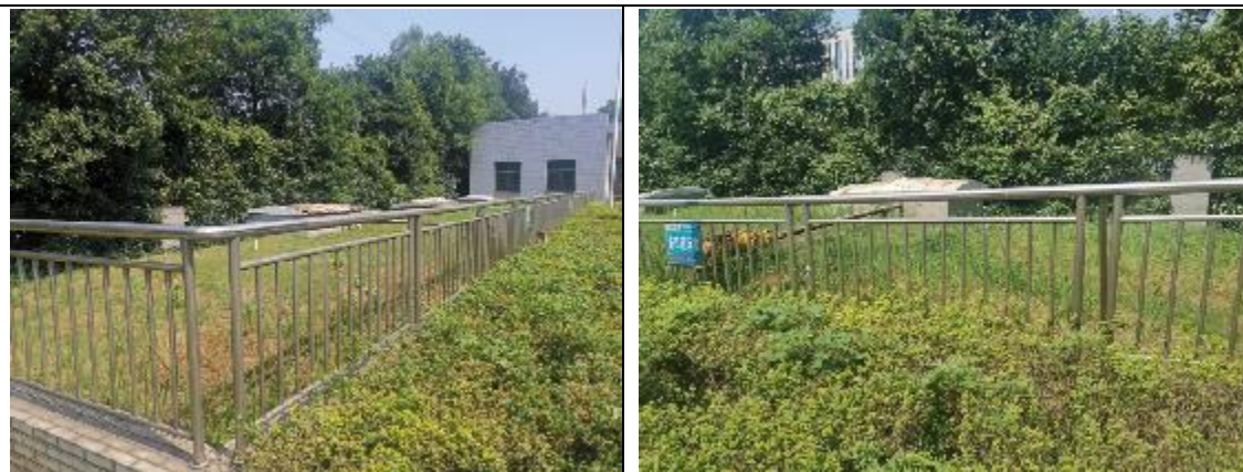
地下油库现场排查照片
