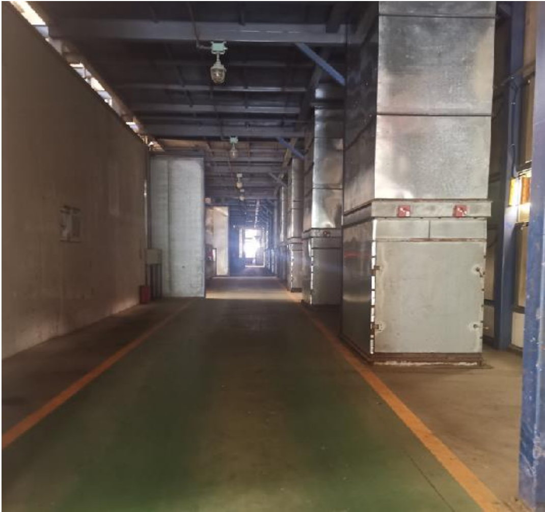
喷涂封闭作业区现场照片
