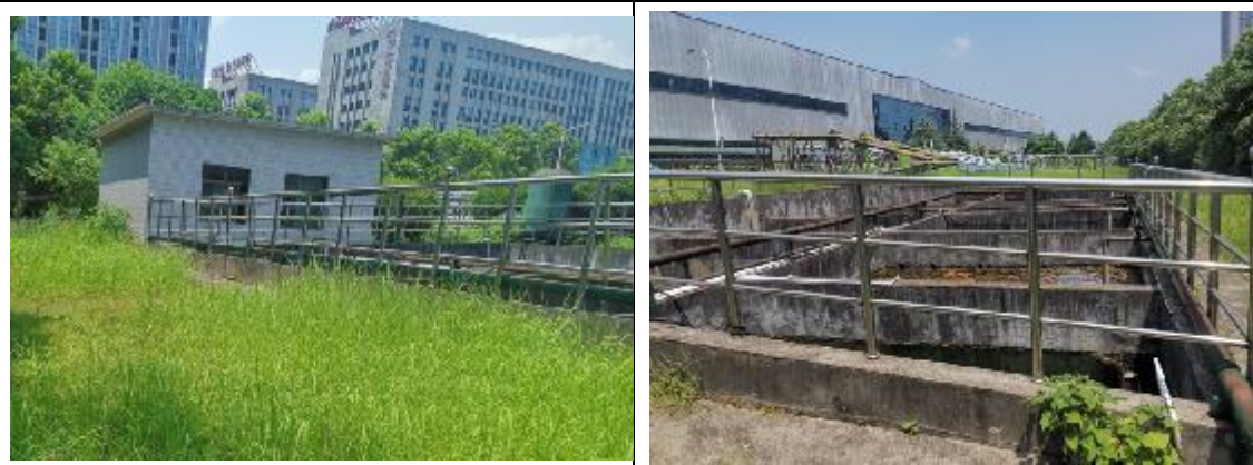
废水处理站现场排查照片
