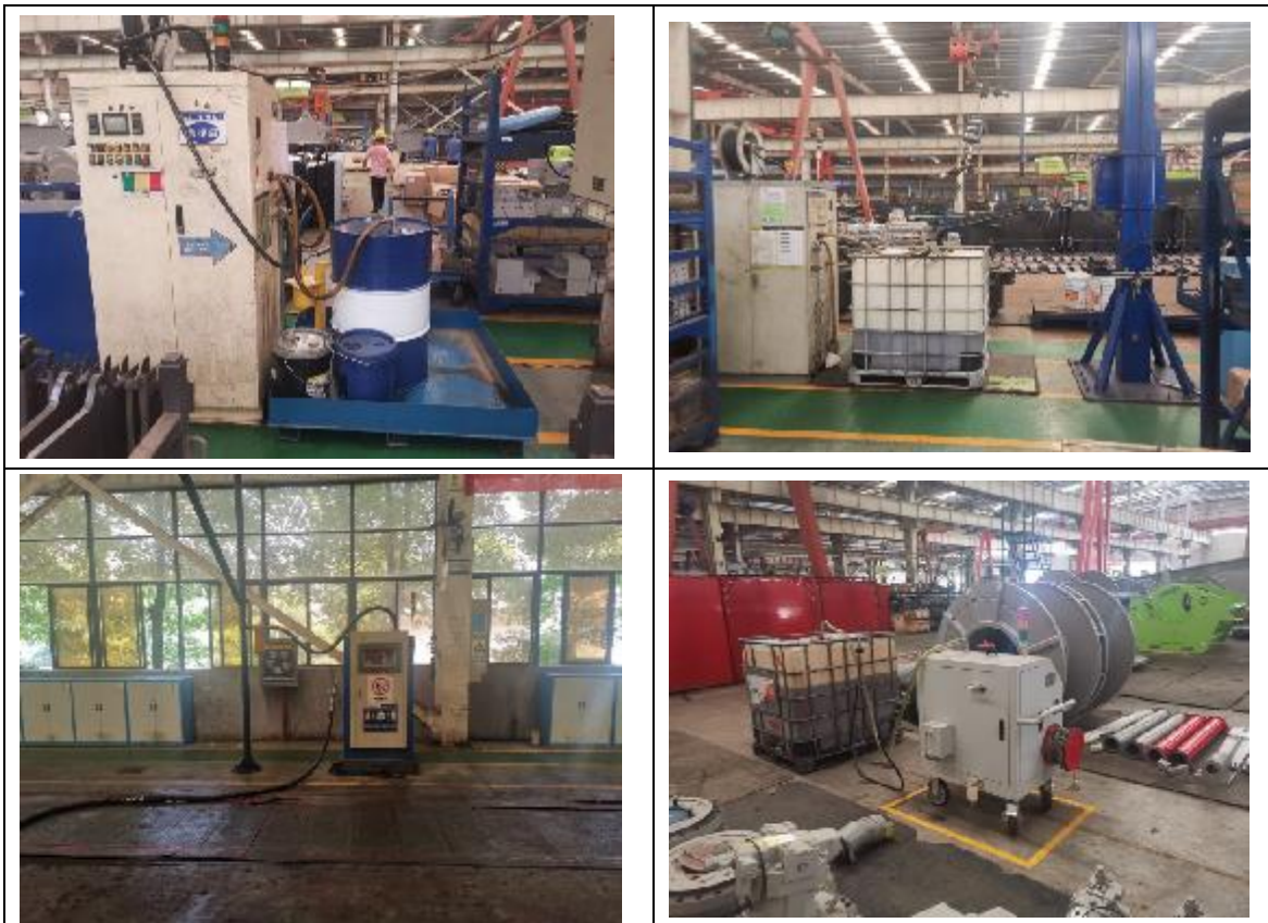
液压油、齿轮油、润滑油加注作业点现场排查照片
