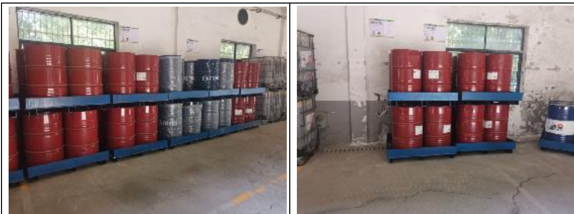
地上油库现场排查照片
